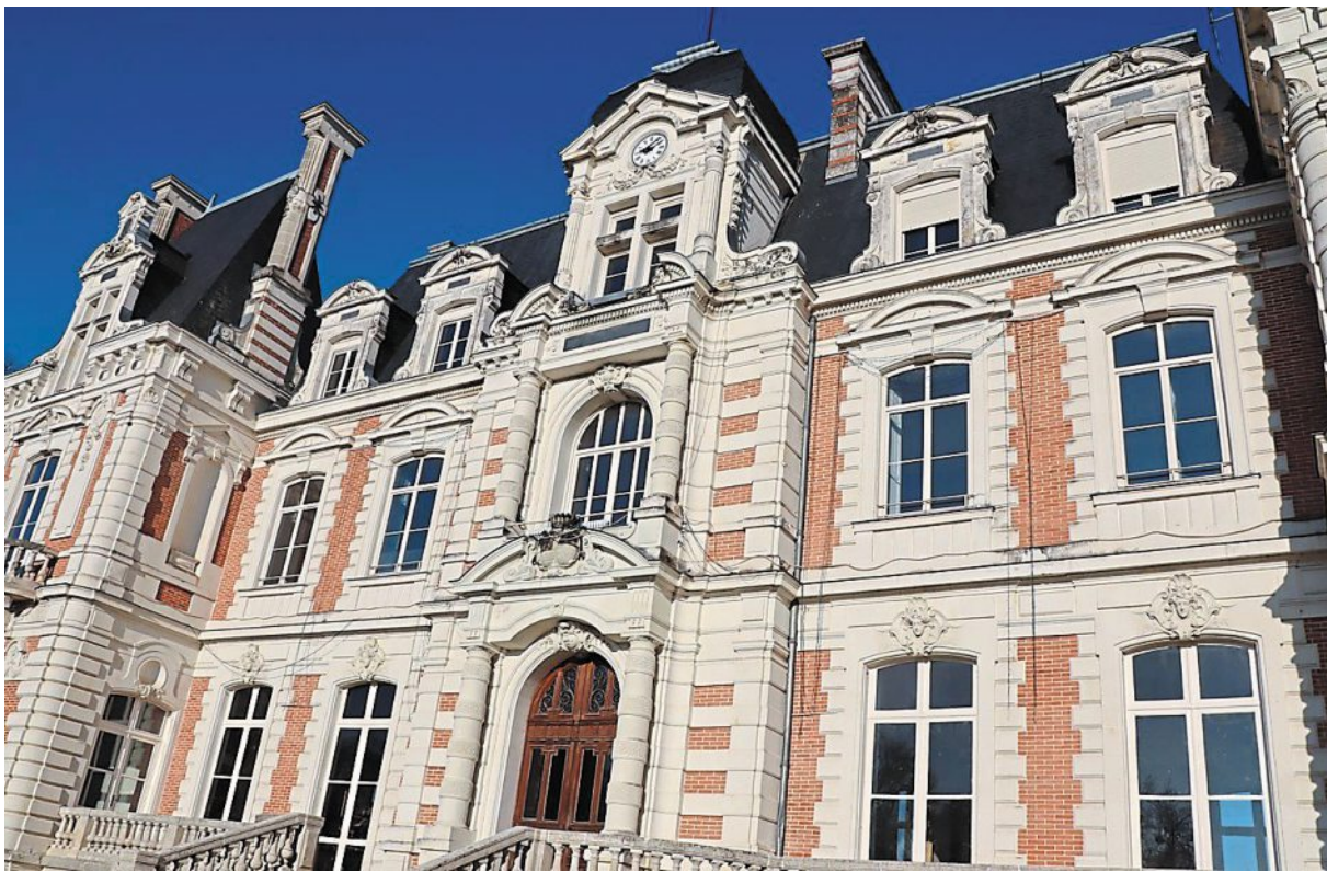
Les chambres des internes sont aménagées dans le château de La Bruère-sur-Loir.
